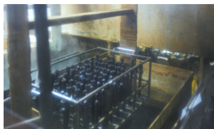
コンプレッサーの洗浄
